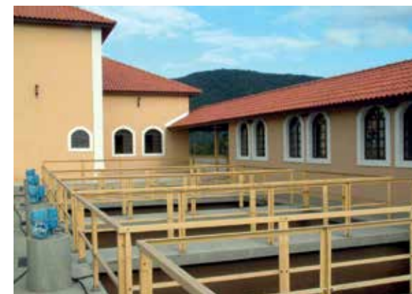
Figura 8.2: Estação de tratamento de água Lagoa de Peri
