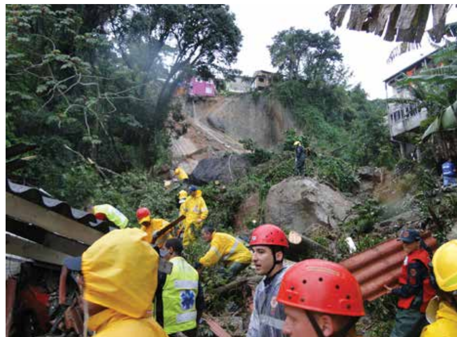
Figura 8.26: Deslizamentos em Florianópolis
