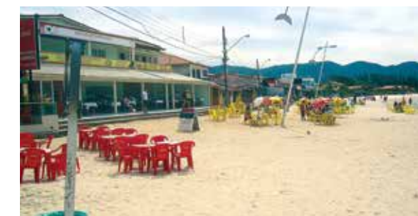
Figura 5.21: Edifícios típicos em Barra da Lagoa
